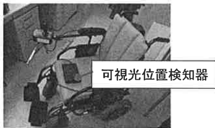
図 12 可視光位置検知器の設置状況
